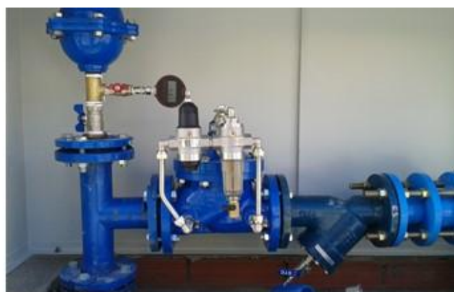
Figura 4: VRP - Regulação fixa e instalação
